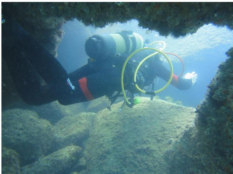
Figura 61: Operatore subacqueo nel passaggio sotto un arco formatosi dall'incastro dei tetrapodi, profondità 3,5 metri;
