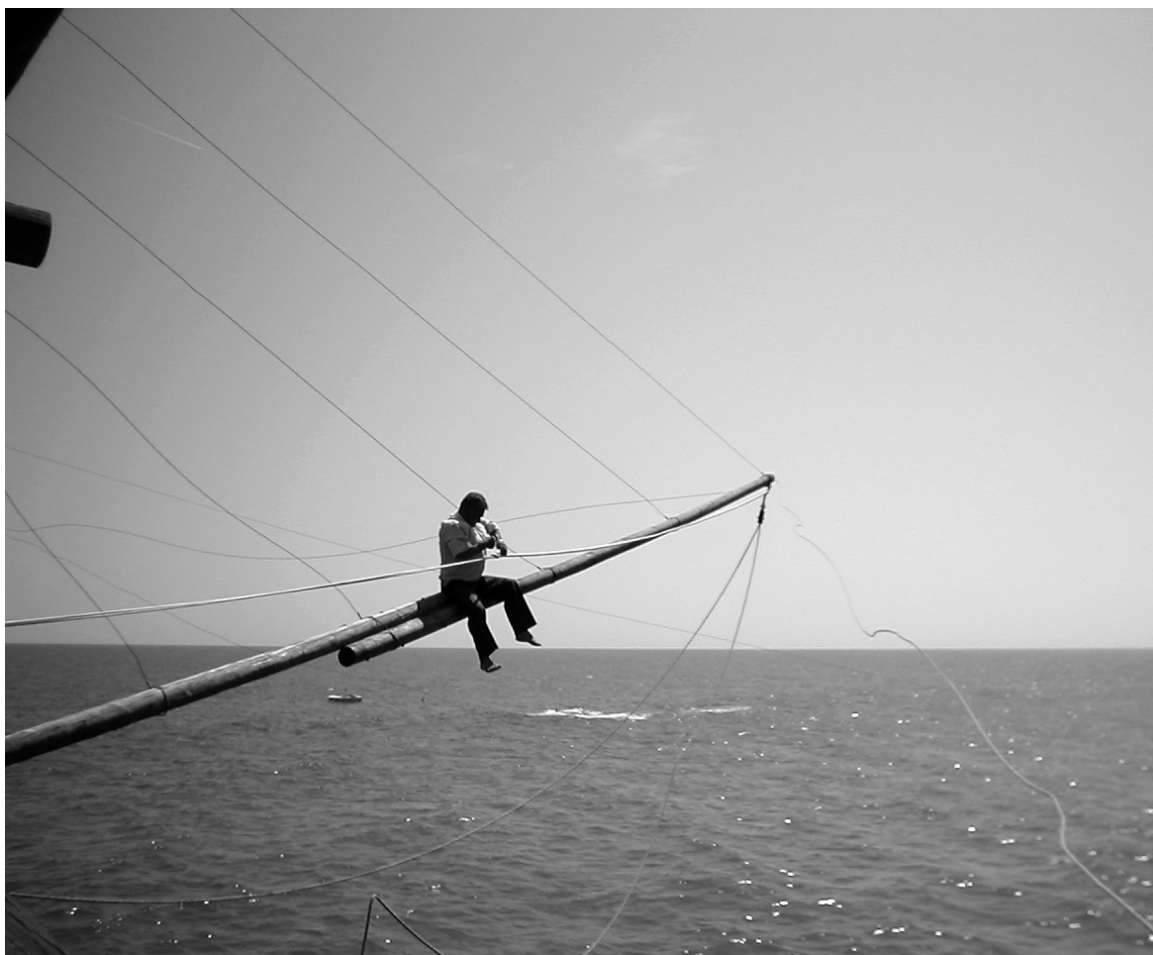
FIG.12 b4 Foto storiche della costruzione di un trabocco- Turchino 2004
