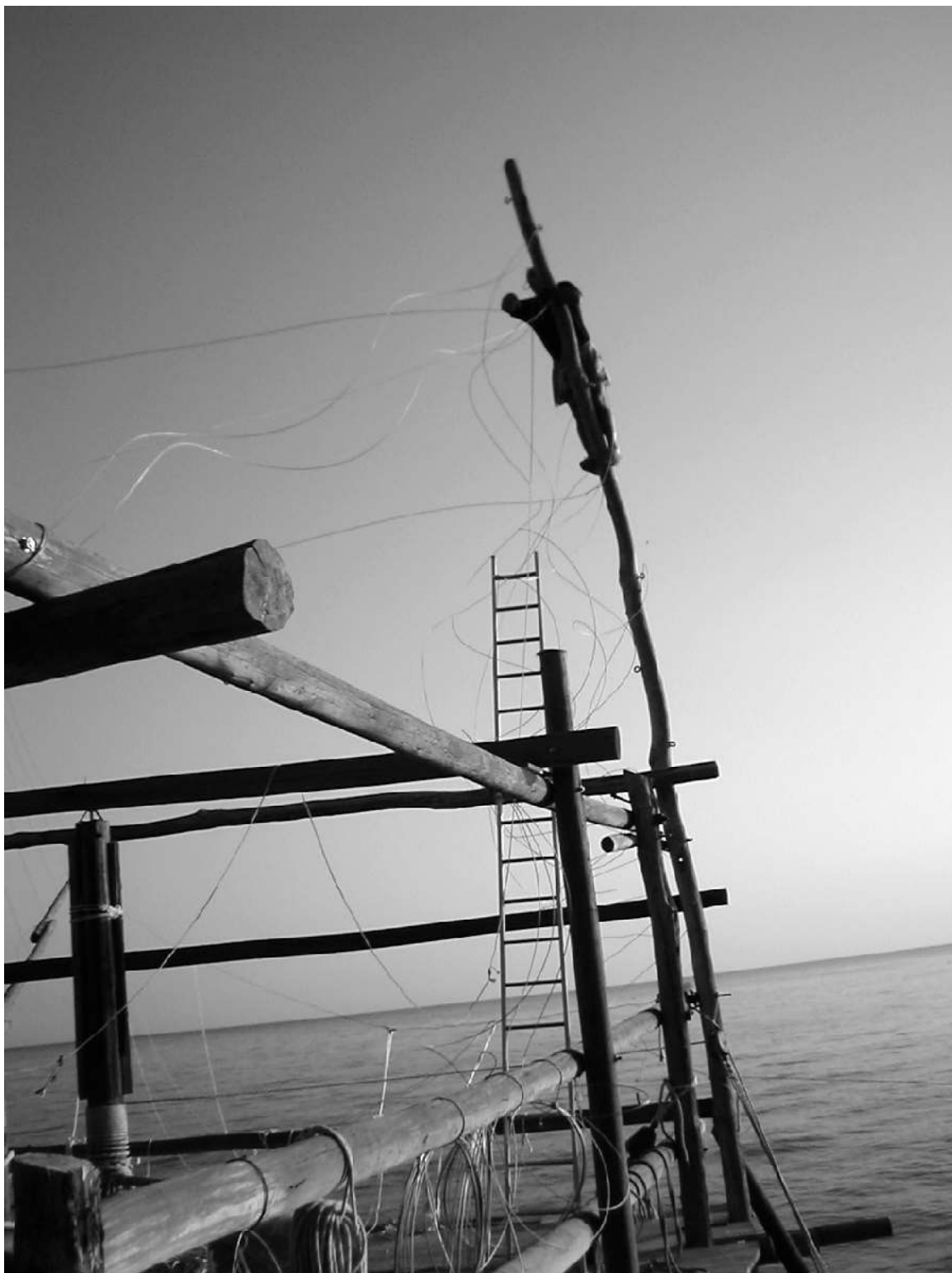
FIG.12 b2 Foto storiche della costruzione di un trabocco- Turchino 2004
