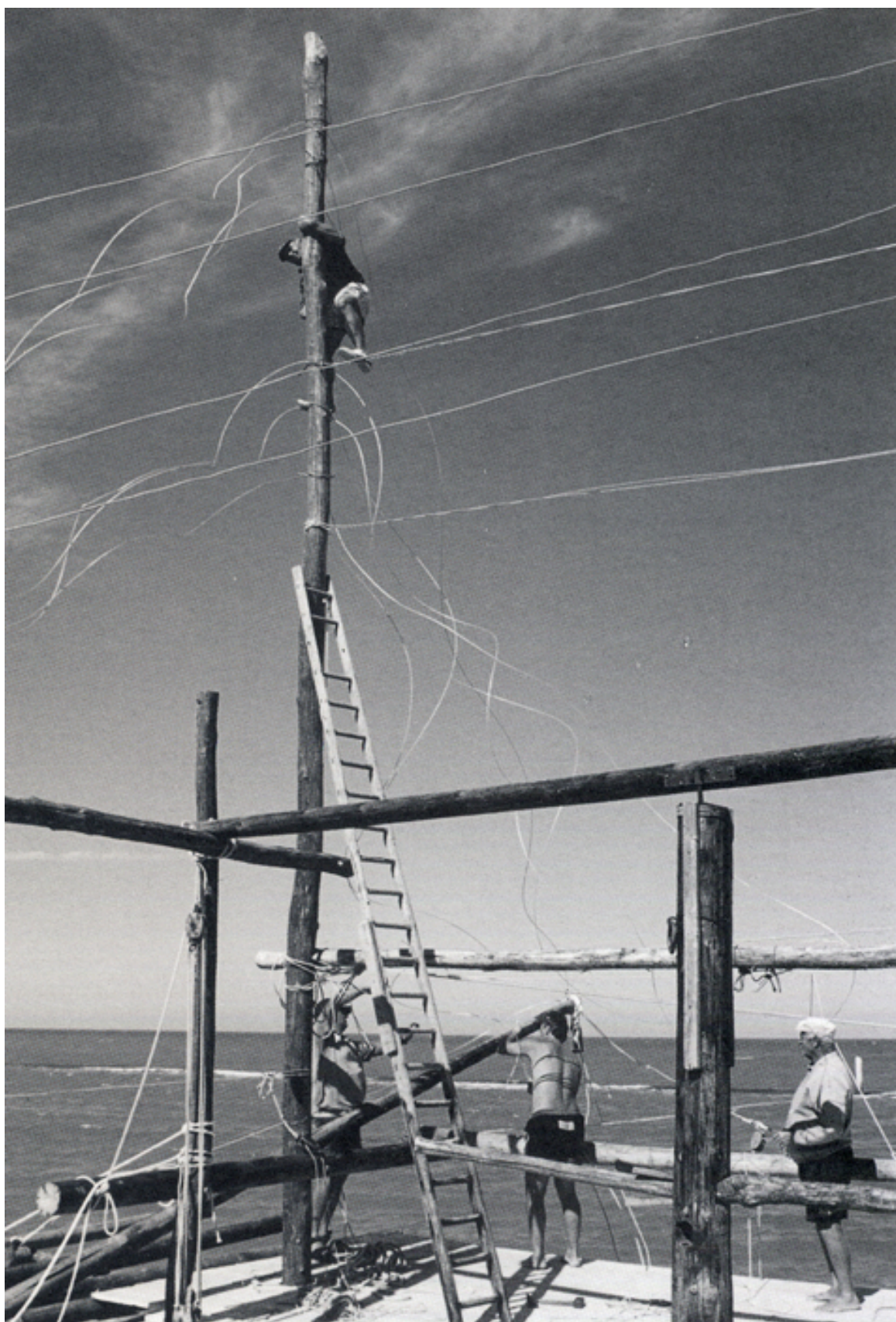
FIG.12a2 Foto storiche della costruzione di un trabocco
