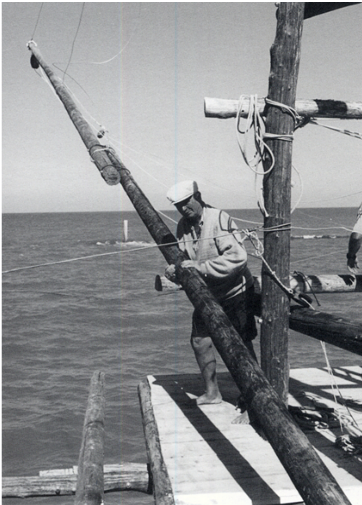
FIG.12 a3 Foto storiche della costruzione di un trabocco
