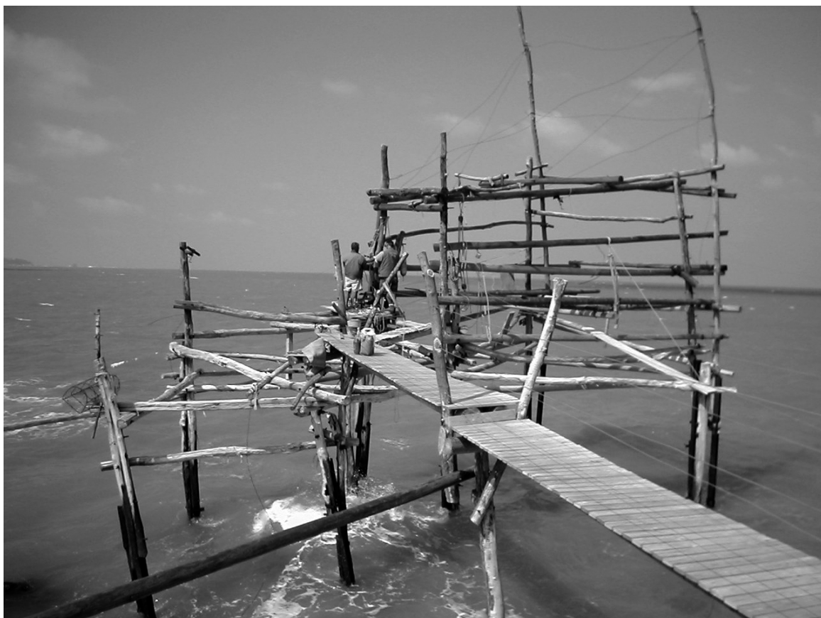
FIG.12 b1 Foto storiche della costruzione di un trabocco
