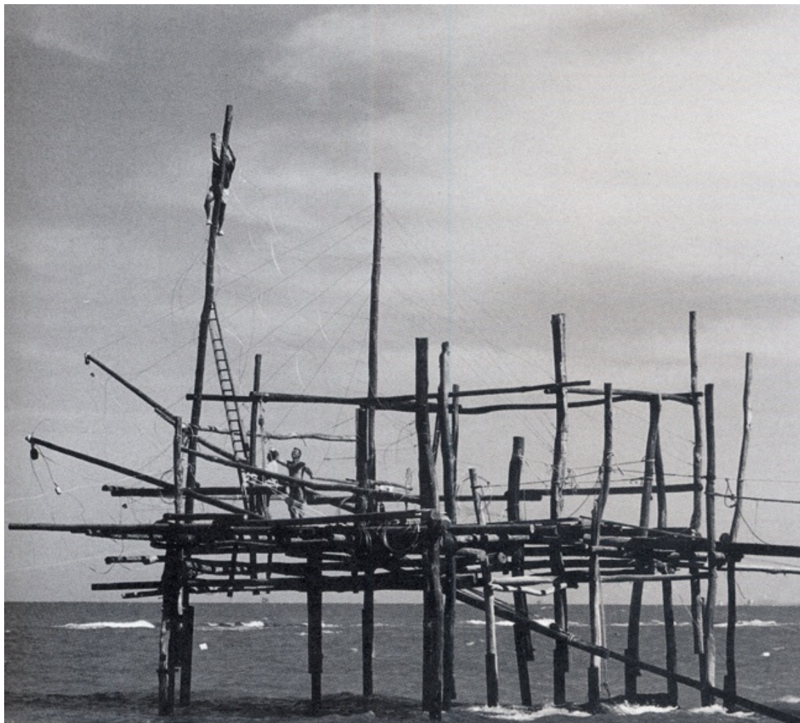
FIG.12a1 Foto storiche della costruzione di un trabocco
