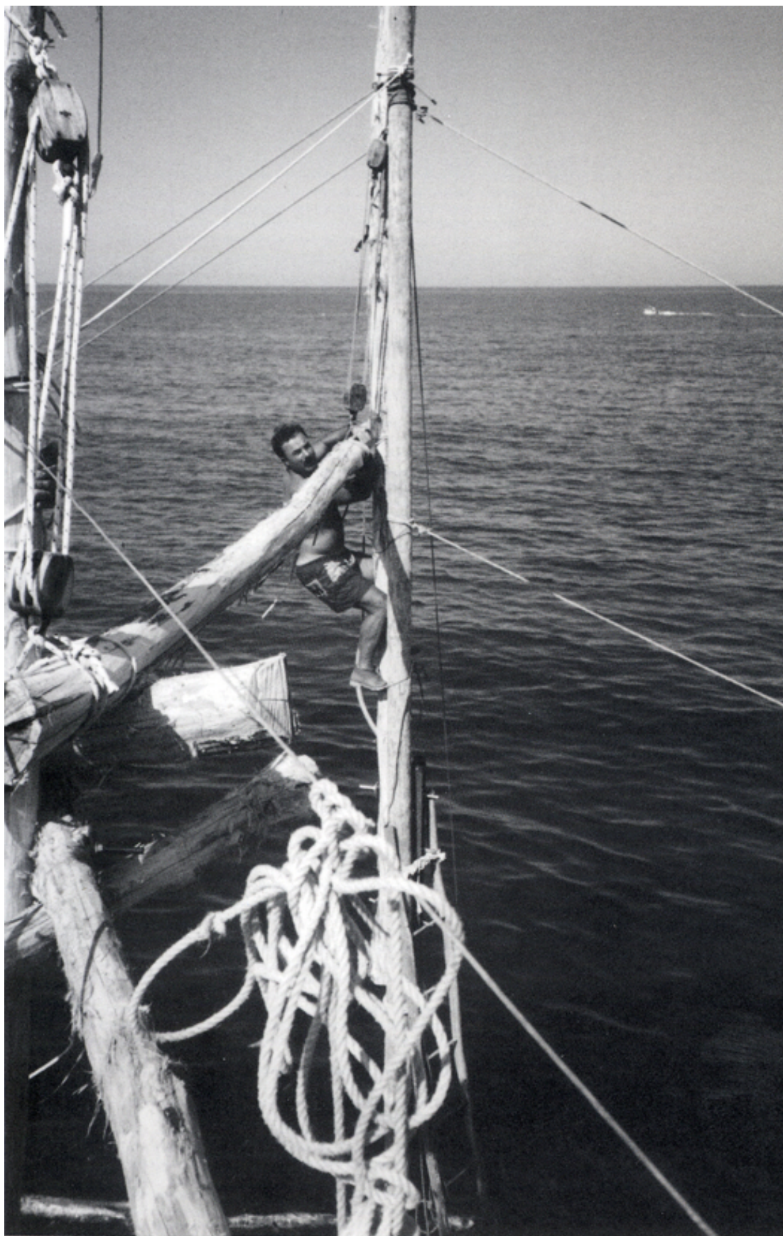
FIG.12 a4 Foto storiche della costruzione di un trabocco
