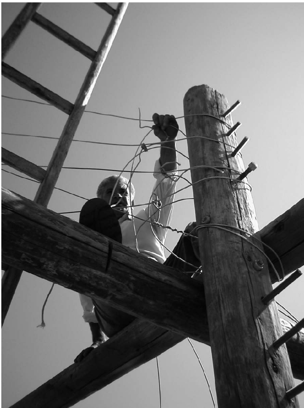
FIG.12b3 Foto storiche della costruzione di un trabocco-Turchino 2004
