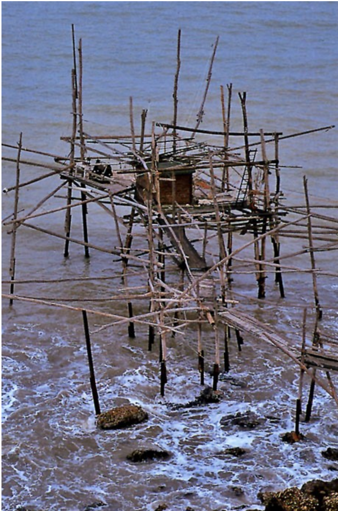
FIG.3b Trabocco di scoglio
